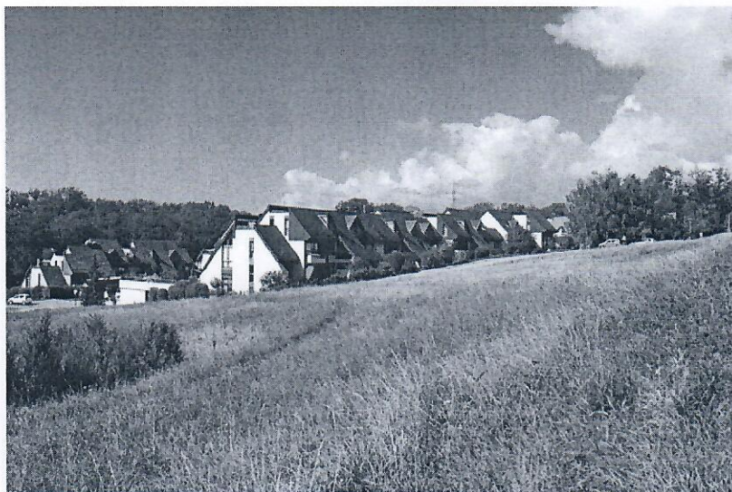
La parcelle destinée à la construction de l'immeuble, avec le quartier résidentiel des Tines en arrière-plan.
